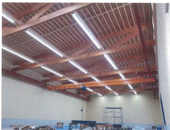
LVL トラスでスパン 19m の天井を支え、同時にクレーン全体を吊り下げる形で支えている。クレーンを操作しても建物は振動が少なく堅牢。
