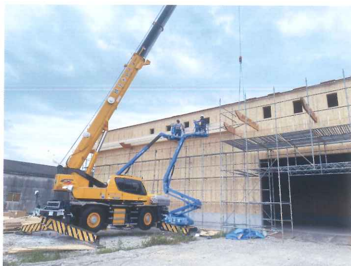
カナダ産 OSB の 3 × 10 サイズを使用した壁パネルをクレーンを使って設置。パネル化は中大規模建築で工期短縮に大きな効果を発揮する。
