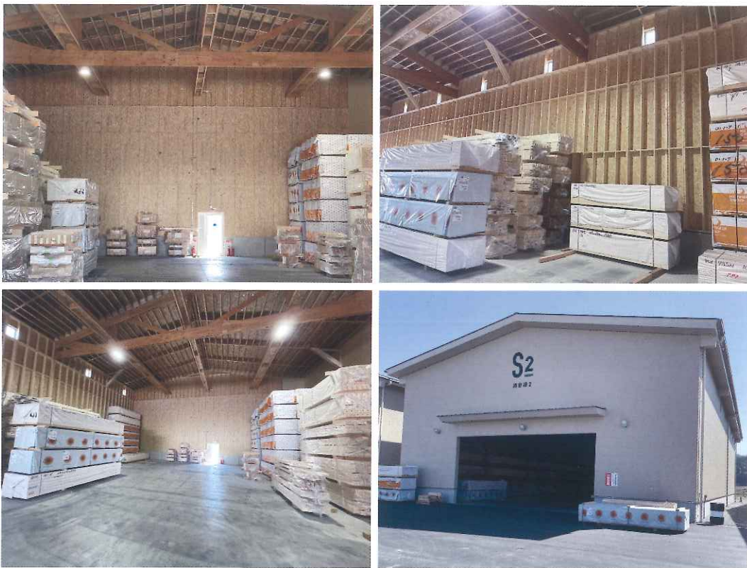
カナダ産 OSB を壁・野地に使用した木造倉庫
