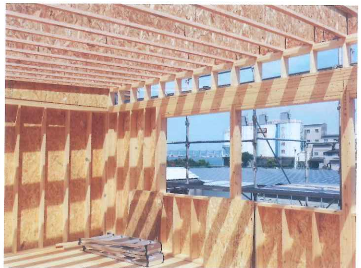
屋根はI型ジョイストで支え、野地にカナダ産OSBを採用している。
