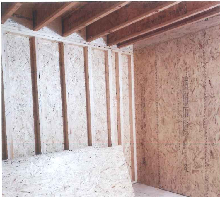
ツーバイフォー工法のパネルで実現したプロジェクト。壁の強度を高めるために、カナダ産 OSB の APA 大臣認定仕様を使用した。
