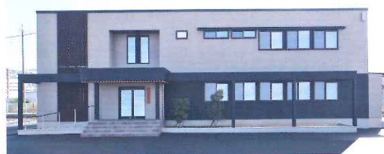
シャープな印象に仕上げた新事務所の外観。各種工場や油槽所が並ぶ臨海工業地域に立地している。
