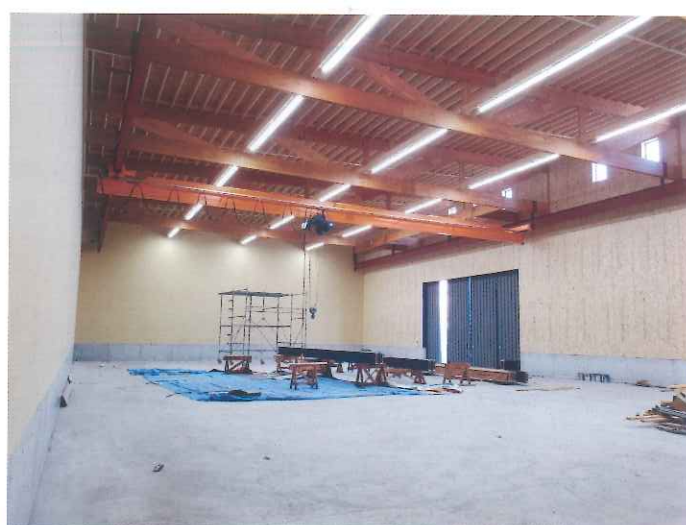
LVL トラスでスパン 19m の天井を支え、同時にクレーン全体を吊り下げる形で支えている。クレーンを操作しても建物は振動が少なく堅牢。
