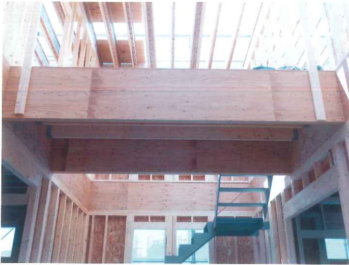
2階床はLVLで組み、最大で8mスパンを飛ばしている。
