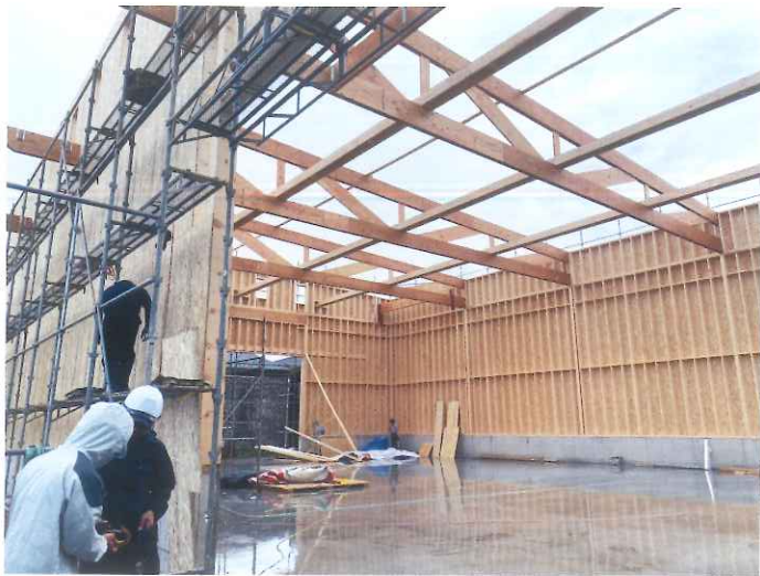
カナダ産 OSB の 3 × 10 サイズを使用した壁パネルをクレーンを使って設置。パネル化は中大規模建築で工期短縮に大きな効果を発揮する。
