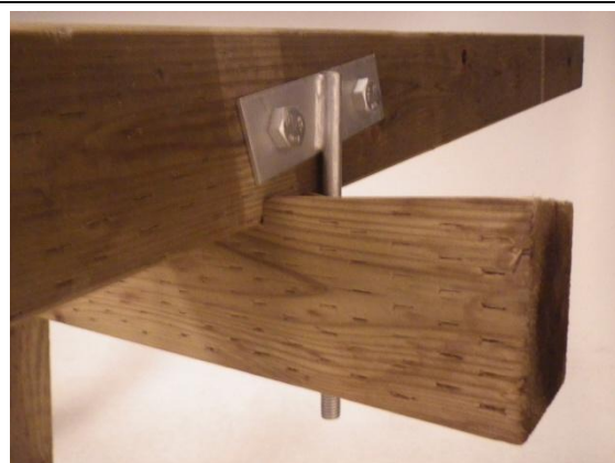
垂木接合金物を取付
